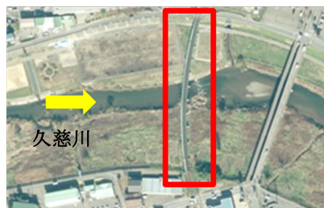
写真-1:久慈川鉄道橋の航空写真(国土地理院 (2013 年撮影)を加工
