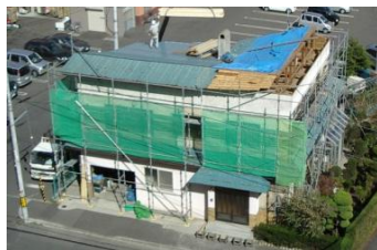
図1 小屋組の強風被害
