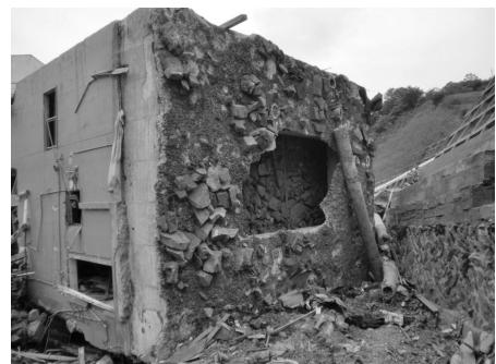
写真4 転倒したRC造建物 (No.2) : 摩擦杭基礎
