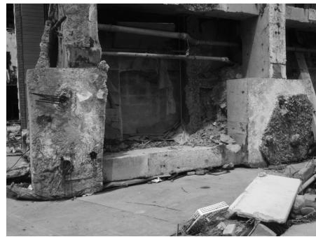
写真10 パイルキャップに残された鉄筋（後面側）
