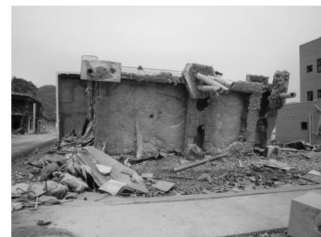
写真6 転倒したRC造建物 (No.3) : 支持杭基礎
