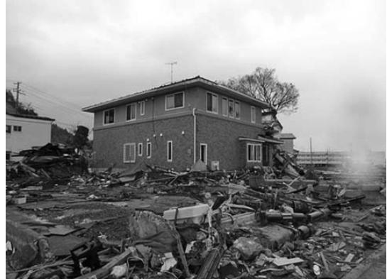
写真4 津波で流されなかつた枠組壁式とみられる
