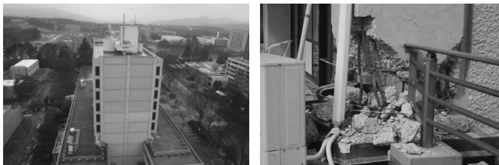
写真1 東北大大学工学部の人間・環境系研究棟と3階柱脚部の被害
