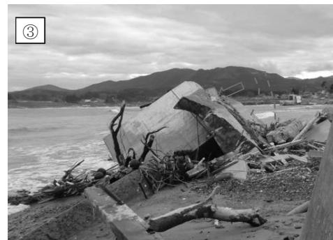
図3 海側に傾斜した護岸 (2011年4月撮影)
