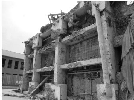
写真1 転倒した鉄骨造建物 (No.1) : 支持杭基礎
