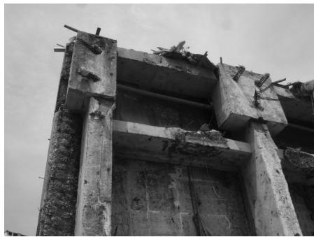
写真9 パイルキャップに残された鉄筋（前面側）
