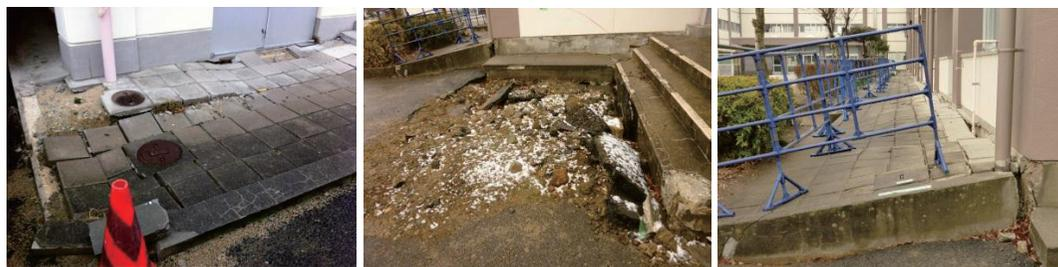
図 13 使用不可能となった建物の地盤沈下
