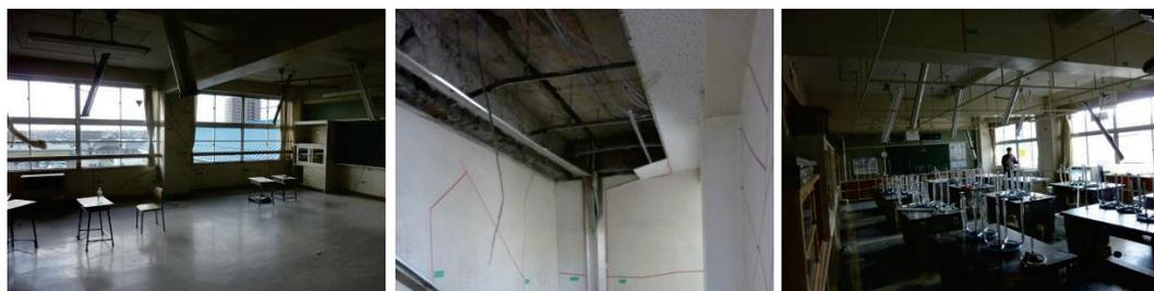
図 14 使用不可能となった建物の建築設備の被害
