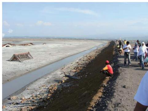
写真-1 汚泥の氾濫・堆積状況および仮設堤防
