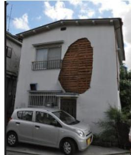
写真 15 外壁材の剥離
