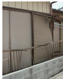
写真 18 雨戸の被害
