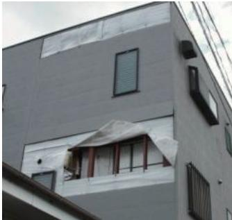
写真 14 外壁材の剥離
