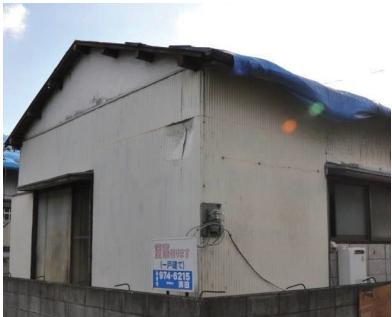
写真 13 飛来物による損傷
