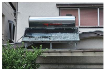
写真 24 温水パネルの被害②
