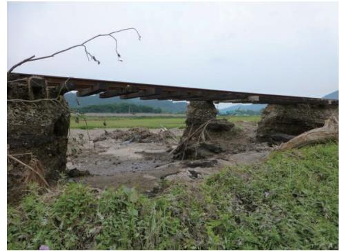
図-8 線路盛土の被災状況、近景 (8/16撮影)
