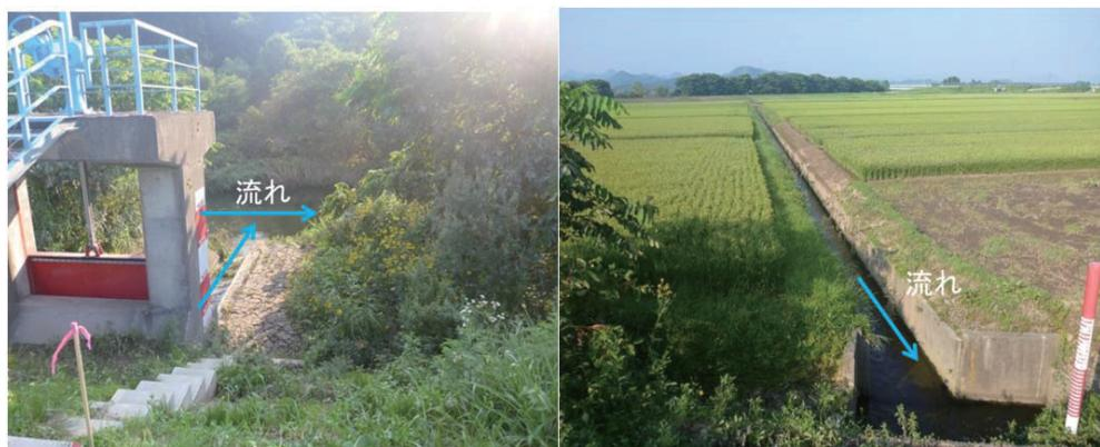
図-8 引欠川の破堤箇所の直上流に位置する水田からの排水路。右は引欠川の排水路から水田側を撮影
