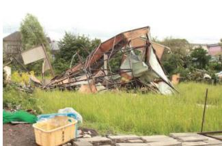
写真 1 上部構造の飛散
