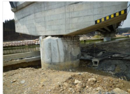
写真-1 津波により橋脚が圧壊した歌津大橋
