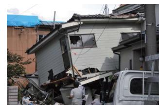
写真 6 上部構造の倒壊
