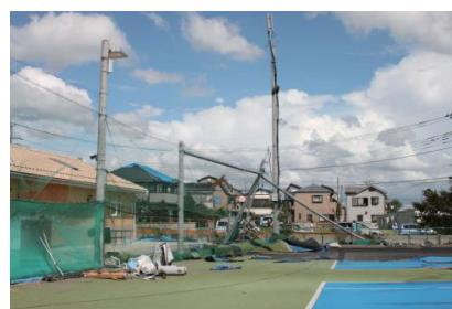
写真 26 支柱の傾斜
