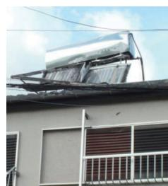
写真 23 温水パネルの被害①
