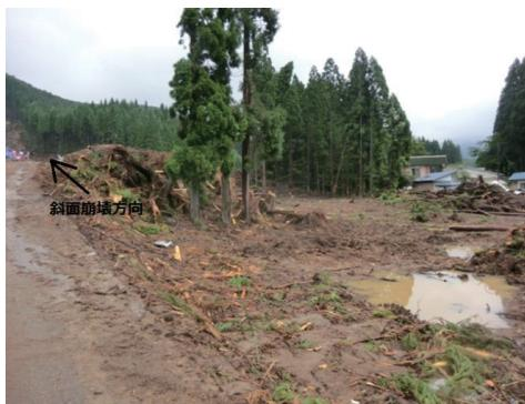
図-3 道路盛土を越えた土石流の被害の様子
