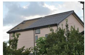
写真9 瓦の剥離被害
