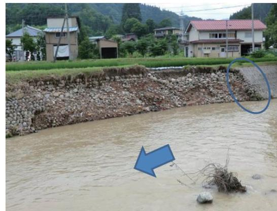
図-8 月布川における石積護岸の崩落被害の様子
