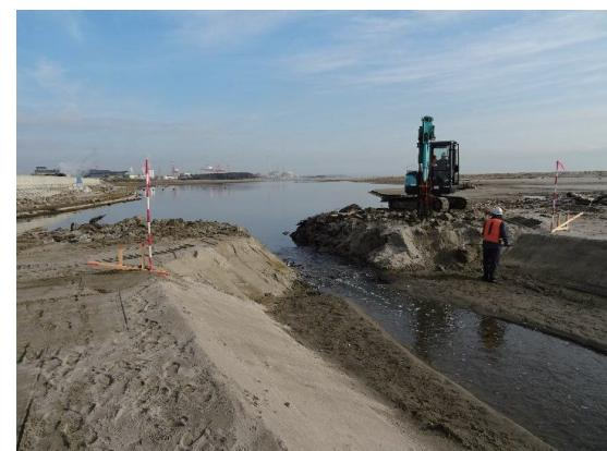
図-9 蒲生干潟通水部の掘削（2015年12月23日）
