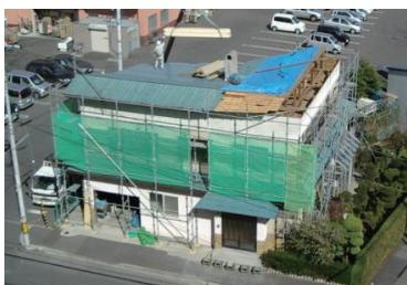
図1 小屋組の被害
