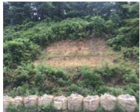
図-1 表層崩壊が確認された現場
