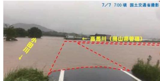
図-5 小田川と高馬川の合流地点直下流における破堤氾濫状況(国交省撮影。破堤延長は約100 m)
