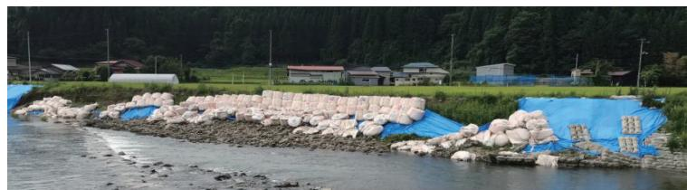
写真-1 洗掘が生じた左岸の様子（2018 年 8 月 22 日撮影）
