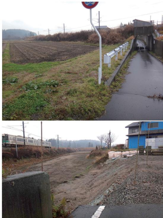
図5 JRの盛土を越えて洪水流を通したアンダーパス(下)と道路と宅地の侵食が発生したアンダーパスの出口側。
