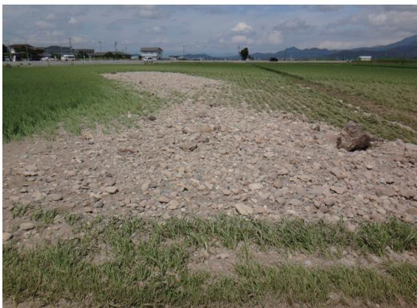
図 8 破堤によってもたらされた堤防を構成していた砂礫の堆積
