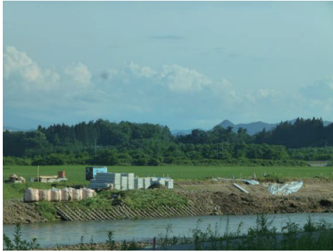
写真-1 堤防の被害
