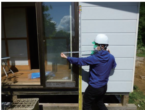
写真-3 民家への浸水被害
