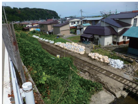
写真-12 線路の復旧の様子
