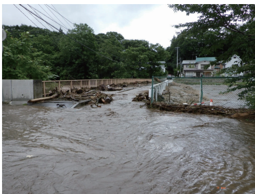
写真-1 岩根橋左岸の越流
