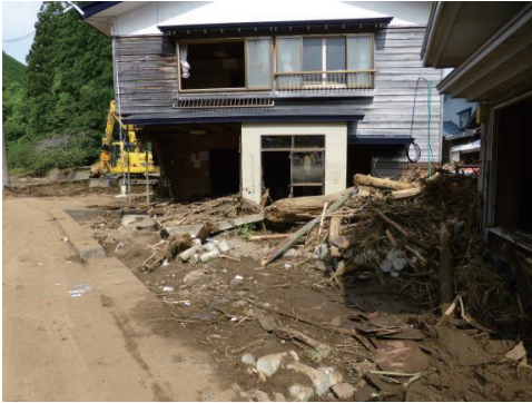
写真-15 流木による民家への被害
