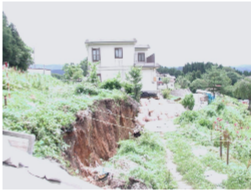
写真－3 地すべり頭部の滑落崖
