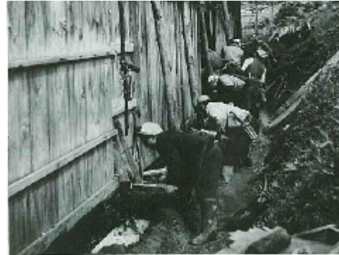
写真－2 被害住宅の補修(昭和 30 年代)
