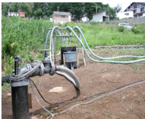
写真－5 緊急工事 デープウエル
