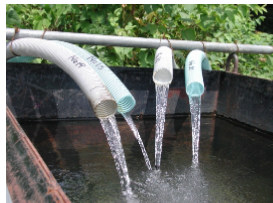
写真－6 デープウエル排水状況
