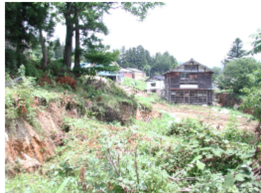
写真－4 地すべり頭部の滑落崖
