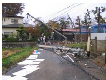
図6 電柱の折損
