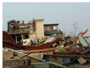
図4 全壊した木造作業所
