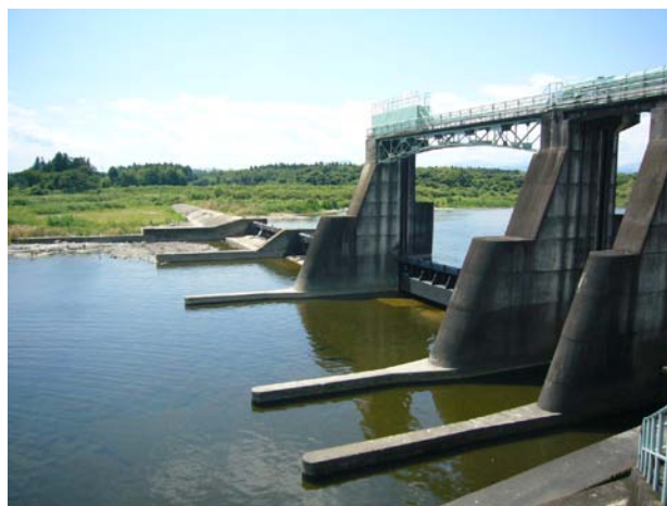
図-1 一部可動堰の例（栃木県鬼怒川筋佐貫頭首工）
