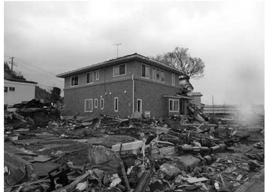
写真4 津波で流されなかつた枠組壁式とみられる
