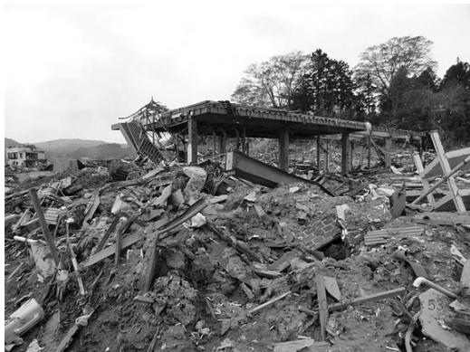
写真1 外装材が流されて残った鉄骨建物
