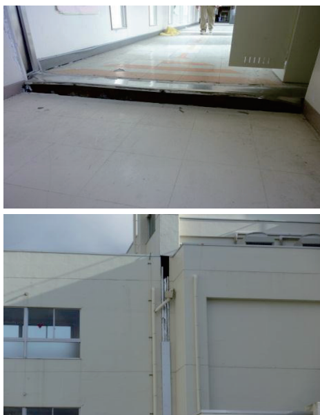
図11 直接基礎の建物のEJのずれ
