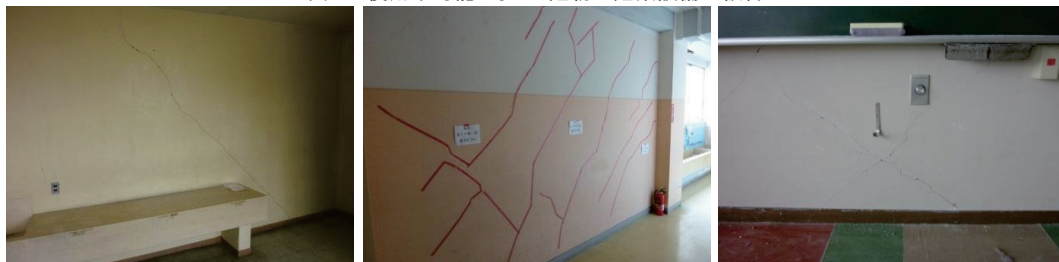
図 15 使用不可能となった建物の使用者に心理的抵抗を与えるひび割れ
