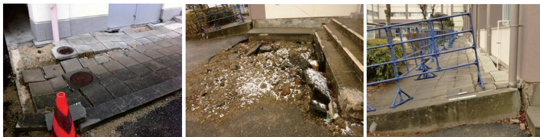
図 13 使用不可能となった建物の地盤沈下
