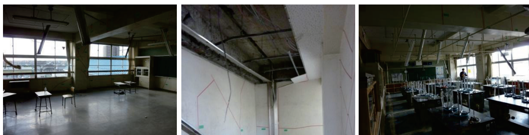
図 14 使用不可能となった建物の建築設備の被害
