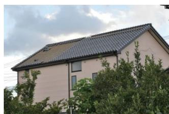
写真9 瓦の剥離被害
