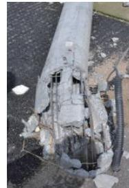
写真 27 支柱の被害
