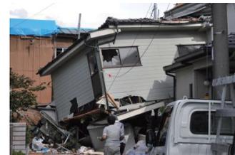
写真 6 上部構造の倒壊
