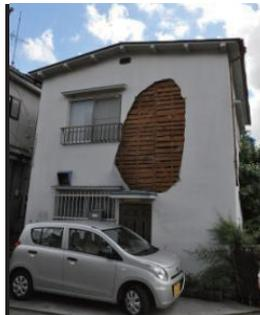
写真 15 外壁材の剥離
