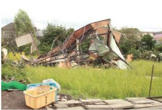
写真 1 上部構造の飛散
