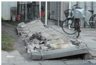
写真 20 ブロック塀の倒壊
