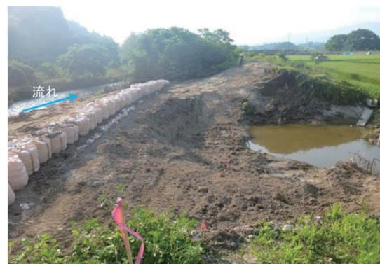
図-7 引欠川の破堤状況とそれを土嚢で応急対応する様子
