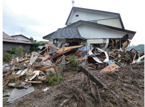
図-6 家屋の被害状況（半壊）
