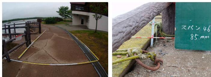
写真-3 護岸の天端コンクリート劣化状況（左：水叩き部のクラック、右：上部工段差）
