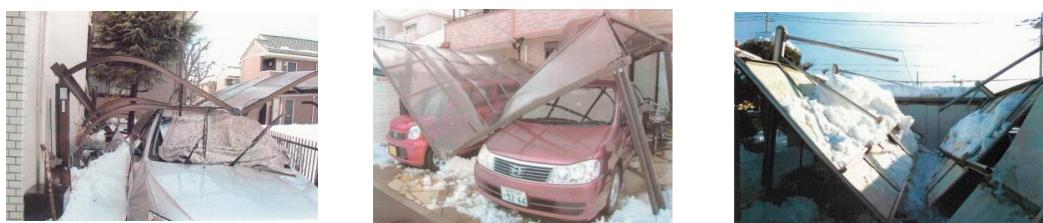
図 13 両側支持タイプのカーポートの被害例(写真提供 : 群馬県前橋市)
