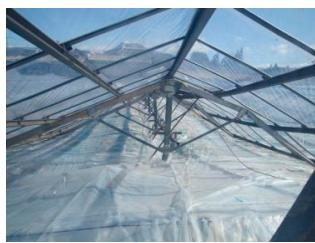
(d)梁の横座屈と塑性変形
