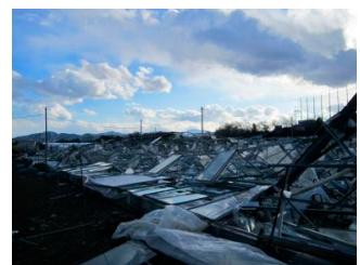
(c)完全に倒壊したガラス室
