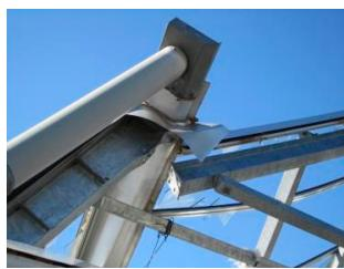
(e)柱・梁接合部ボルトの破断
