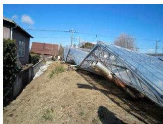
(a)倒壊した鉄骨ハウス
