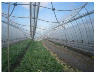
図 6 単棟型パイプハウスの被害
