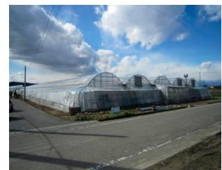
図 8 鉄骨補強パイプハウス
