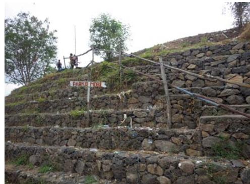
写真1 汚泥氾濫を防ぐために建設された仮設堤防
