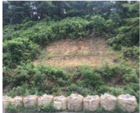
図-1 表層崩壊が確認された現場
