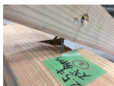
図3 釘打ちのみの接合でみられた破壊性状
