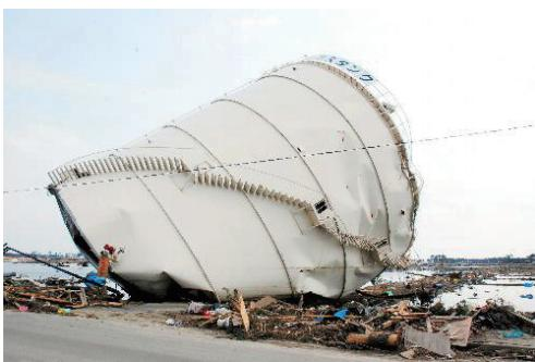
図1 オイルタンクの津波被害
