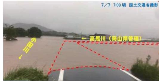
図-5 小田川と高馬川の合流地点直下流における破堤氾濫状況(国交省撮影。破堤延長は約100 m)
