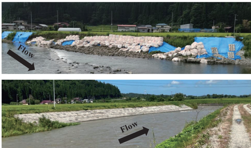
図 9 河川湾曲前における工事前(上)と工事後(下)の様子
