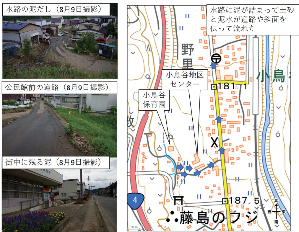
図-1 小鳥谷地区センター周辺道路への水路からの溢水 (国土地理院地図に流れの向きを示す矢印とコメントを追加)
