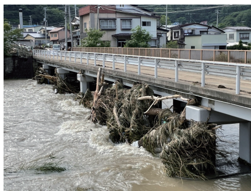
写真-2 岩根橋に堆積する流木 (岩手県庁県土整備部河川課提供)
