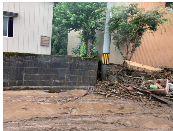
写真-8 住宅への被害
