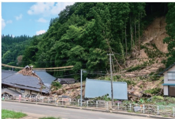
図8 表層崩壊による家屋の倒壊（鮭川村川口）（8月4日撮影）。
