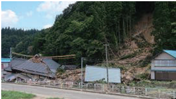
写真1 鮭川村の斜面崩壊と住宅被害
