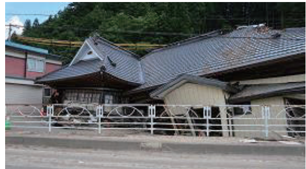
写真2 住宅の層崩壊（写真1と同じ住宅）
