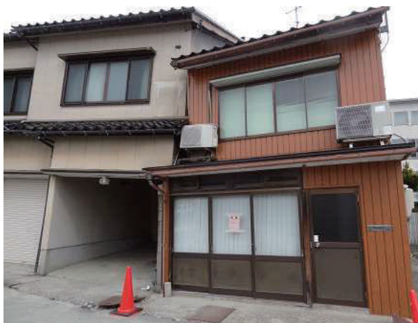
図4 傾斜した建物
