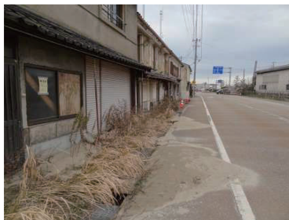
図6 液状化による噴砂
