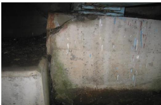
写真-2 判別に用いた劣化損傷状態1の画像
