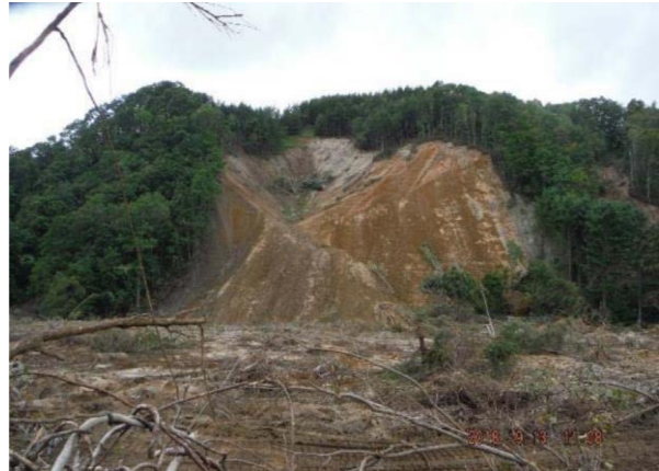
写真-1 斜面崩壊 1)
