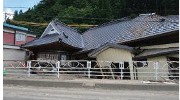
写真2 鮭川村の住宅被害（拡大）
