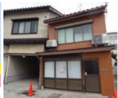
図3 液状化被害の様子
